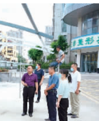
棚施工现场就施工建设情况听取后勤部负责人汇报并进行督导。现场了解到车棚将于一周后投入使用，预计能容纳二百余量电动车（自行车），将能大大缓解职工停车的紧张情况，让职工安心工作。
